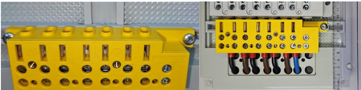
Abbildung 3: Montage Zählersteckklemme
